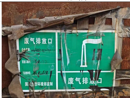
DA002 排气筒标识牌
