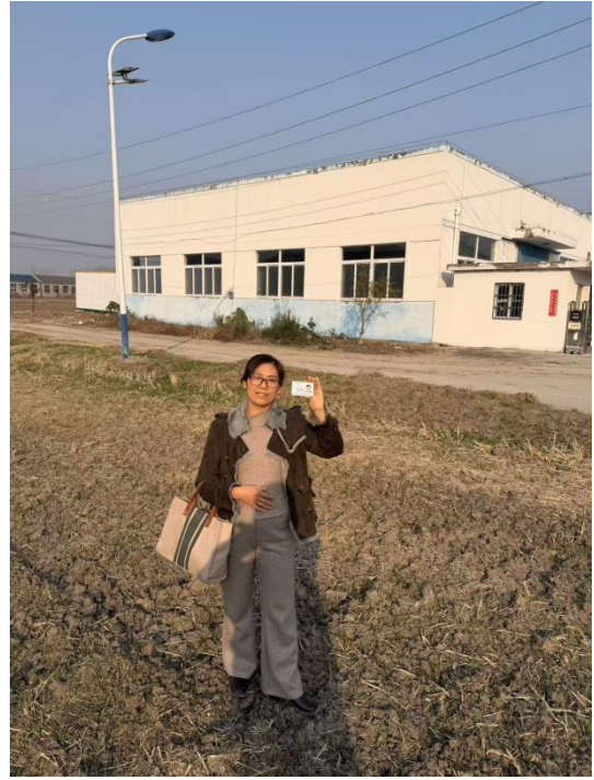
厂房现场照片
