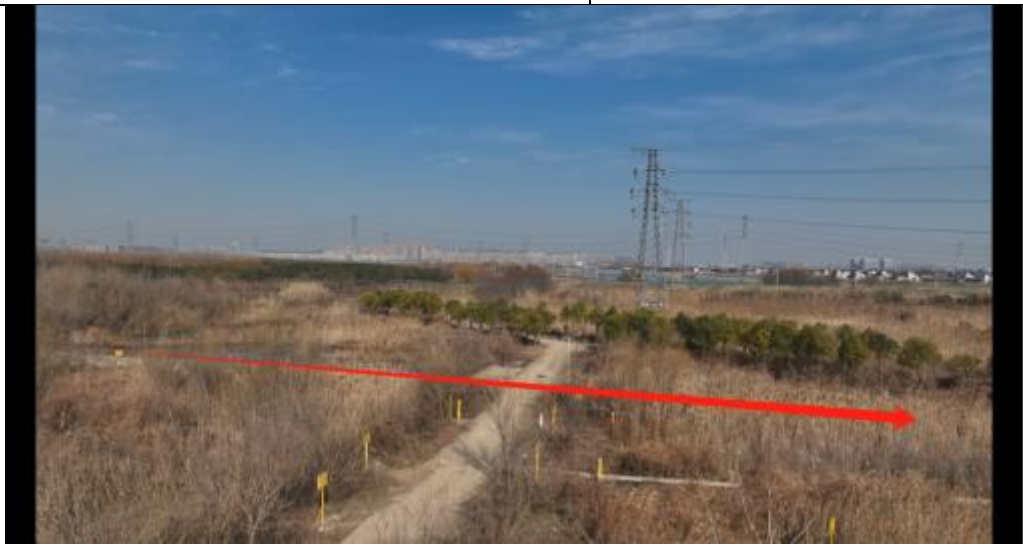
施工后恢复情况（红色为管线走向）
