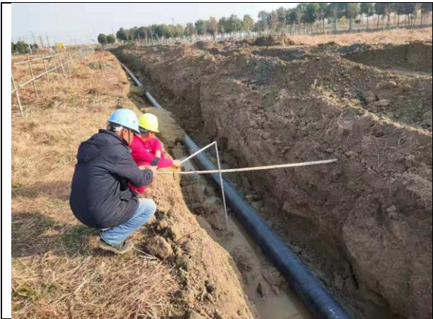
管道开挖现场情况
