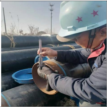
管道施工测量情况
