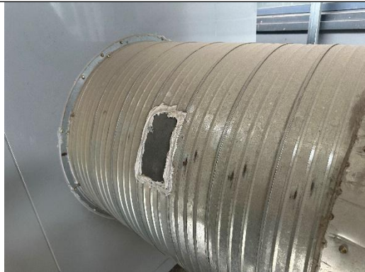
废气处理设施进口采样孔
