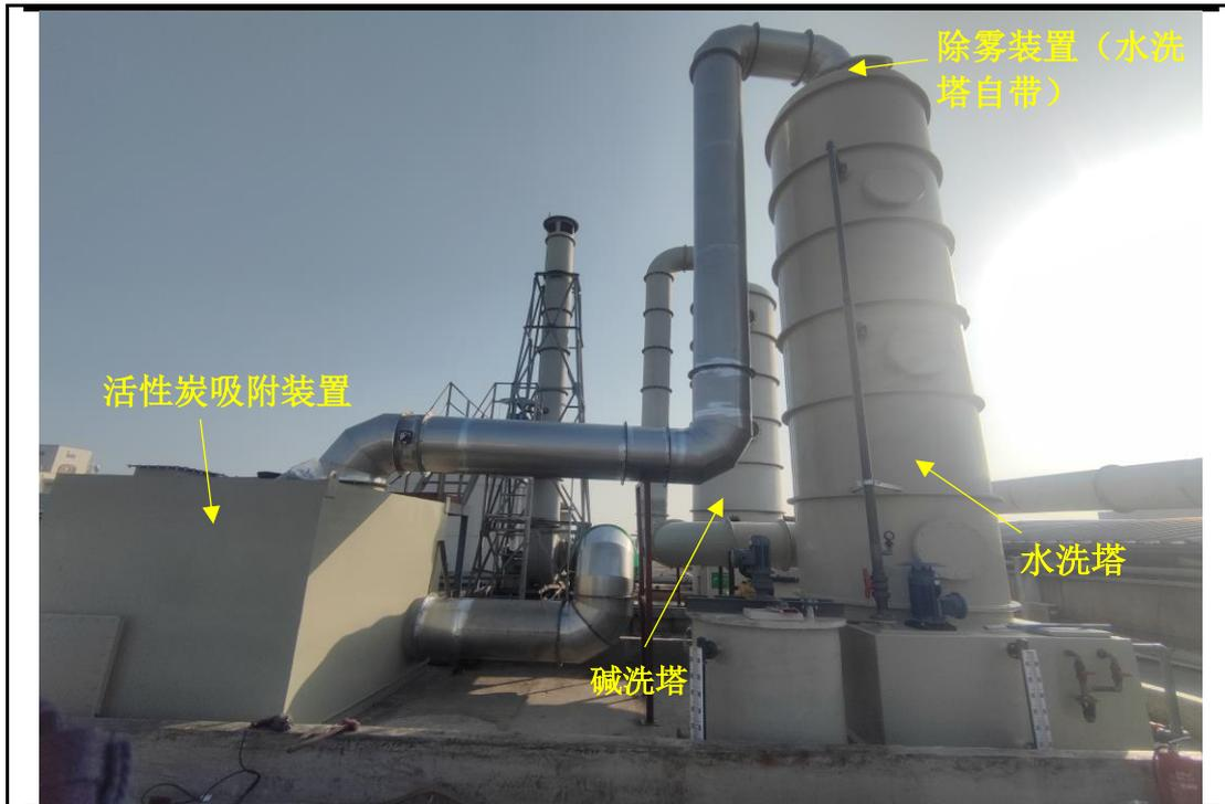
碱洗塔（由水洗塔改造）、水洗塔、活性炭吸附装置
