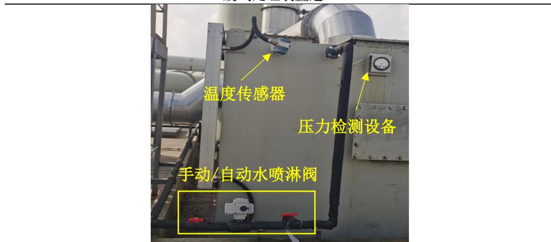
活性炭吸附装置手动/自动水喷淋阀、温度传感器、压力检测设备
