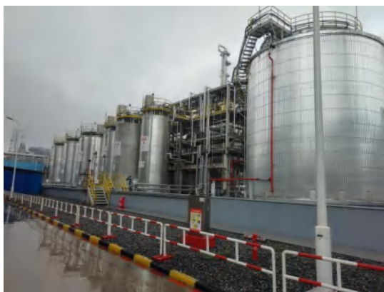
乙醇胺装置和乙烯胺装置新建储罐 10 个（总罐容：3050m 3 ）
