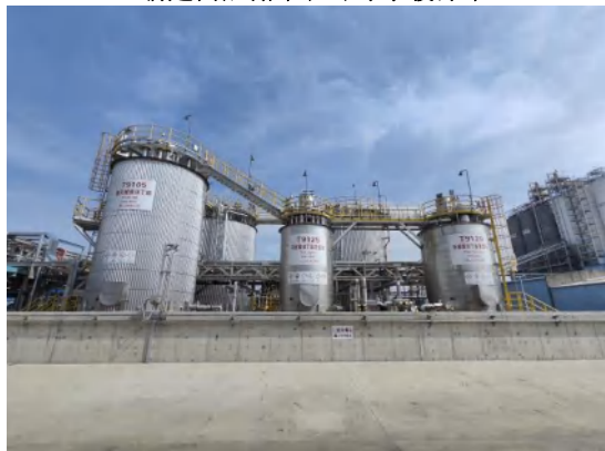
丙烯酸叔丁酯装置（TBA1）新建 5 个储罐（总罐容：1290m 3 ）
