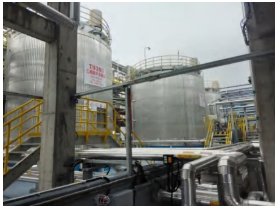
乙醇胺装置和乙烯胺装置新建储罐 10 个（总罐容：3050m 3 ）
