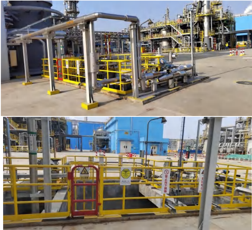
新建初期雨水池
