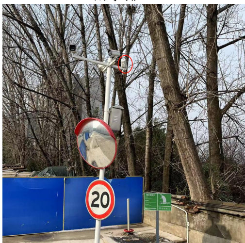
雨水排口监控设施
