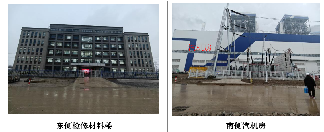
图 3-4 500kV 升压站站内及周边情况
