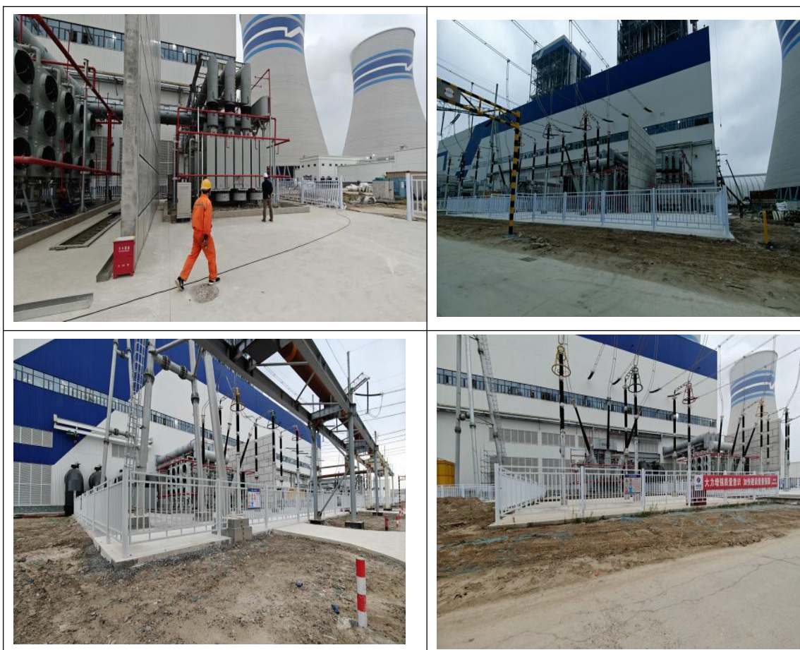
图 6-2 升压站区域生态恢复情况
