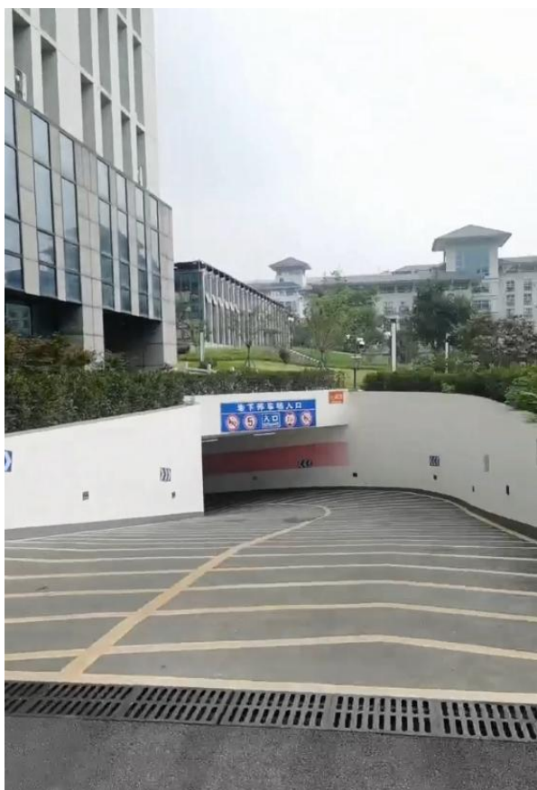
地下停车场入口
