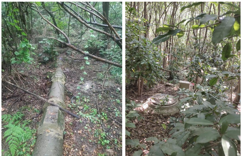
图 3.5-1 山林间敷设的现状管道现场图
