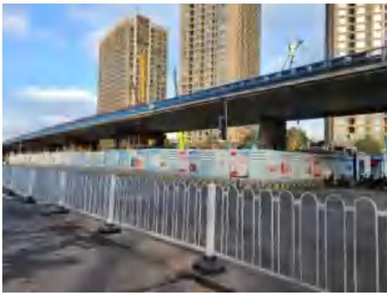
施工区域与沿线居民点之间设置围挡遮挡施工噪声
