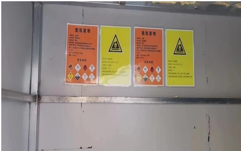
危废暂存间内部标识牌
