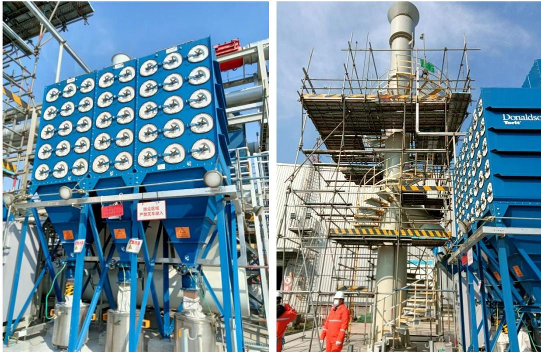
图 3-1a 本项目废气处理设施及排气筒
