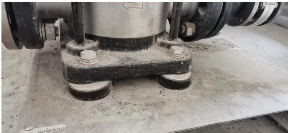
图 3.2-9 泵房设备设置橡胶垫减震措施
