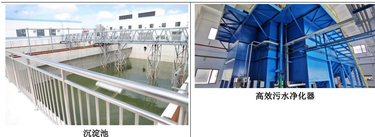
图 3.2-6 含尘废水处理设施照片
