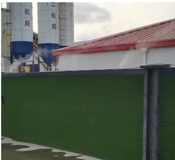
施工围挡配备除尘装置（喷雾）
