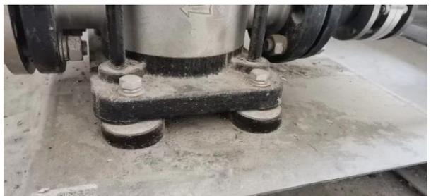
泵房设备橡胶垫减振措施
